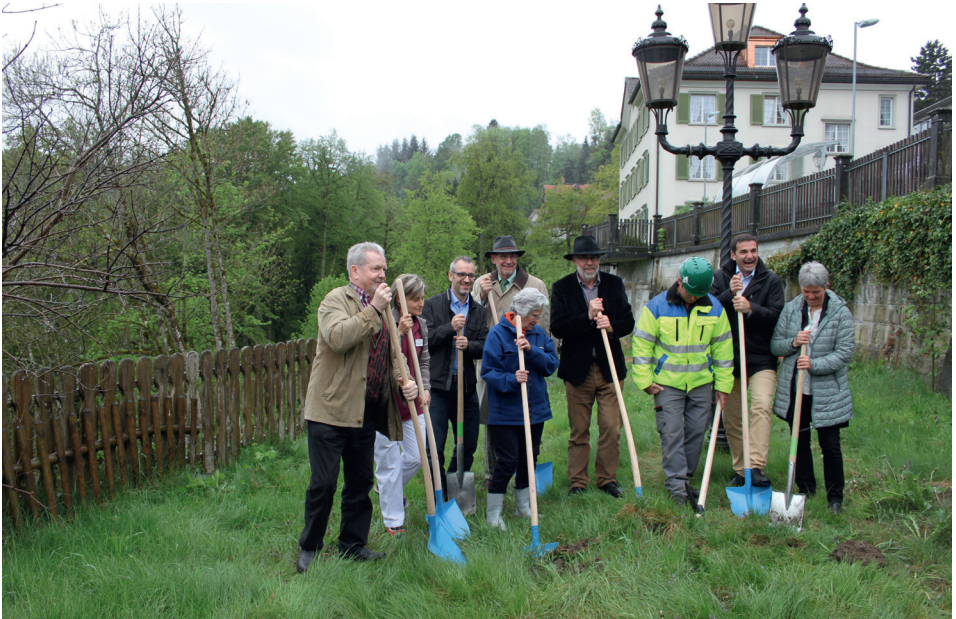
Spatenstich im Mai 2016 mit Bruno Schlegel (4. von links) und Ilir Selmanaj (2. von rechts). Inzwischen geht es mit dem Rohbau voran (oben).
